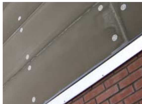
Утепление и отделка наружных стен с помощью плит THERMIT SP
